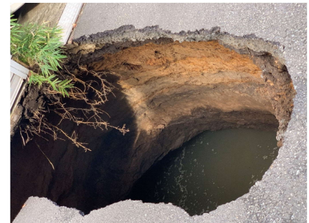
写真6 陥没箇所(2020年10月18日_13:00_西側から撮影)
