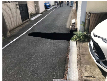
写真4 陥没箇所(2020年10月18日_12:30)
