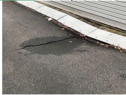
写真3 陥没箇所(2020年10月18日_11:50 舗装亀裂)
